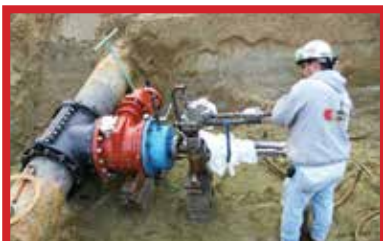
16" X 16" Wet Tap on DI Water Line
