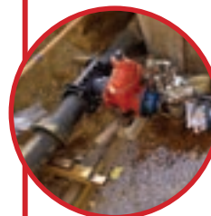
16" X 16" Wet Tap on DI Water Line
